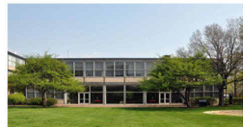
Figura 3: Illinois Institute of Technology: Edificio Perlstein Hall (1950-56). Mies van der Rohe. Fuente: Joe Ruvi. Creative Commons. https://commons.wikimedia.org/wiki/File:IIT_Perlstein_Hall.jpg
