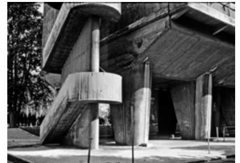
Figura 21: Escaleras y estructura de la Unité d'Habitation de Marsella (1947-52). Le Corbusier. Fuente: Josep Maria Torra. Creative Commons. https://flic.kr/p/7XhHvh
