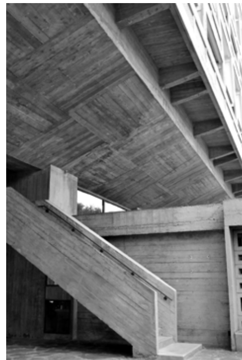
Figura 22: Detalle de texturas de la Unité d’Habitation, de Marsella (1947-1952). Le Corbusier. Fuente: marc. desbordes. Creative Commons. https://flic.kr/p/sA6tUE
